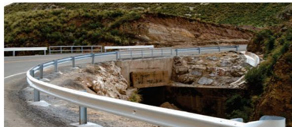
De acuerdo al expediente técnico, el proyecto comprende la construcción y asfaltado de 17+700 kilómetros, 57 alcantarillas circulares de 0.90m, 03 alcantarillas circulares de 1.20 m, 07 alcantarillas de concreto armado, 01 alcantarilla de tipo marco concreto armado; 10,40 m. de cunetas revestidas de concreto, 700 m<sup>3</sup> de encausamiento, construcción de 256 m. de muros de concreto, señalización vial y protección ambiental.
