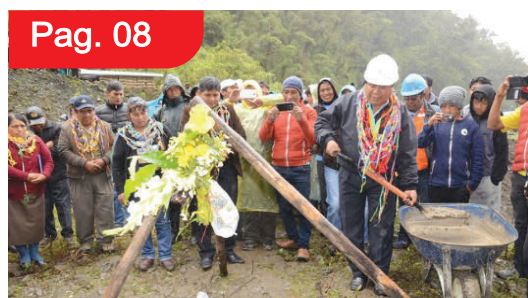
GR. INICIA PUENTE JUCHUY CCASA EN CARRETERA SINA – YANAHUAYA
