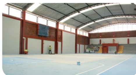
Remodelación del Complejo Deportivo "La Chavela"
