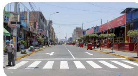
Mantenimiento, Pintado y señalización de vías de todo el distrito.
